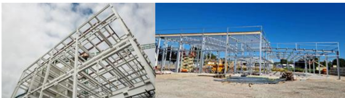
Slika 7: Primer jeklenih konstrukcij
