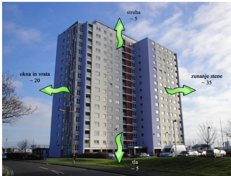
Slika 3: Tipične toplotne izgube skozi ovoj stavbe z okvirno navedenimi prihranki v primeru sanacije, v %
