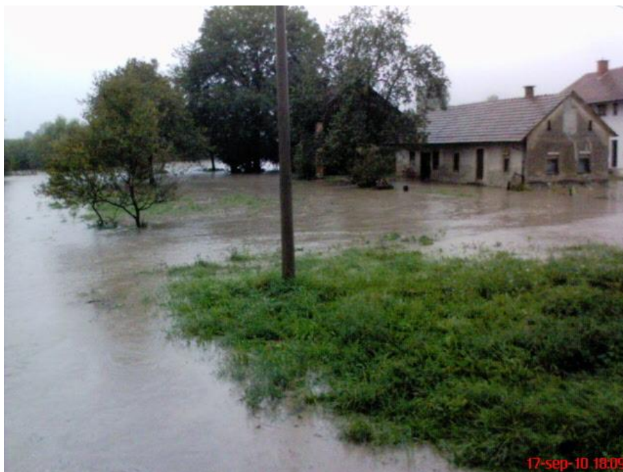
Slika 2: Poplavljen stanovanjski objekt
