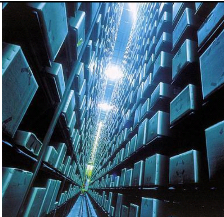
Slika 14: Benettonov skladiščno distribucijski sistem Robostore 2000
