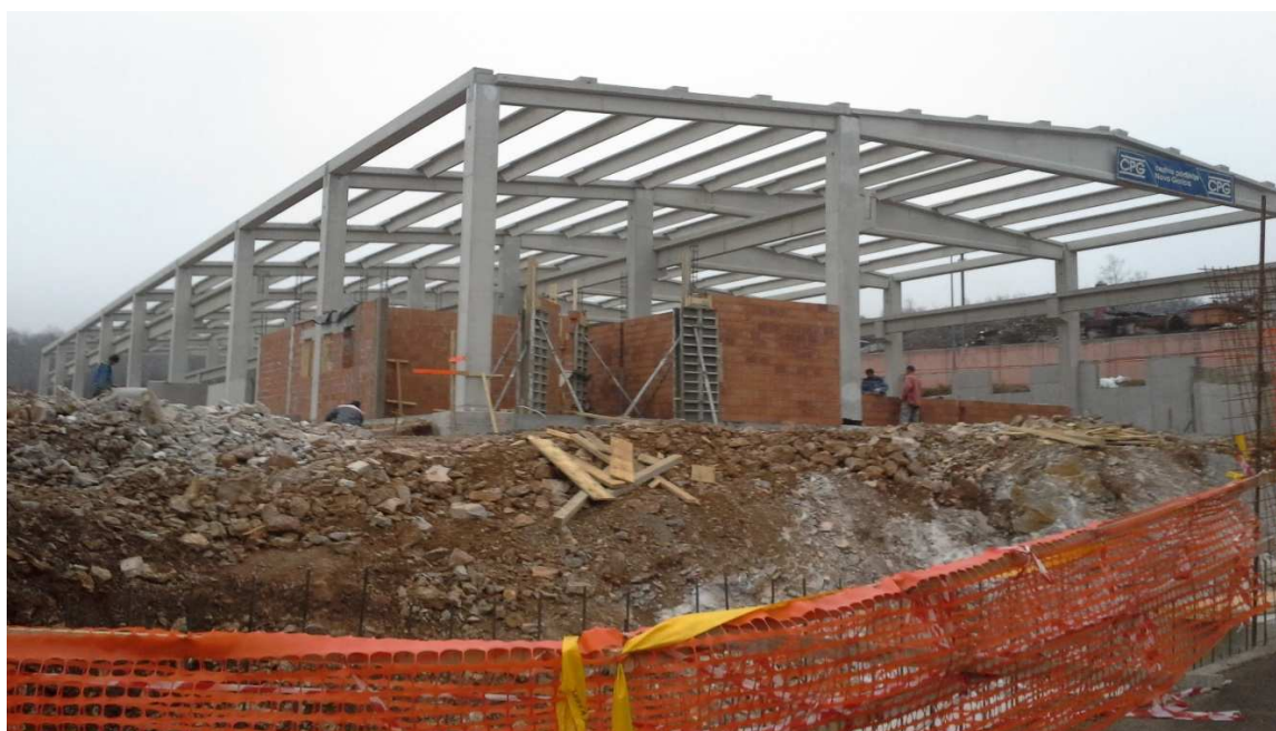
Slika 20: Grafični prikaz pogleda iz vzhodne strani na montažno konstrukcijo in izvedbo pisarniškega dela
