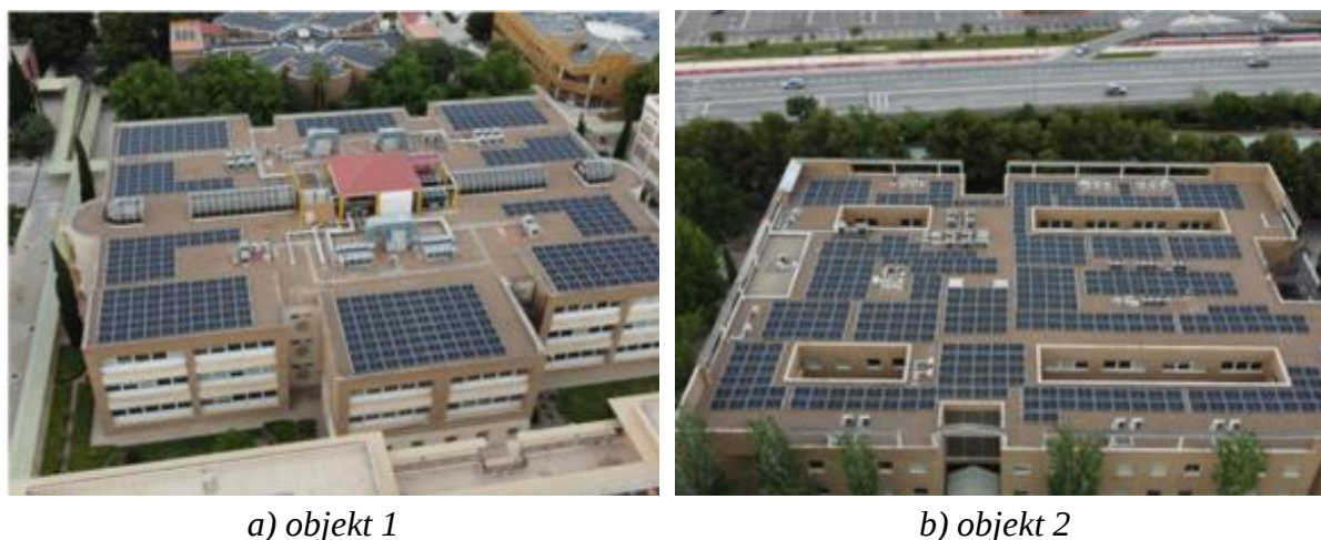
Slika 9: Fotovoltaični sistemi na dveh objektih Univerze v Jaénu
