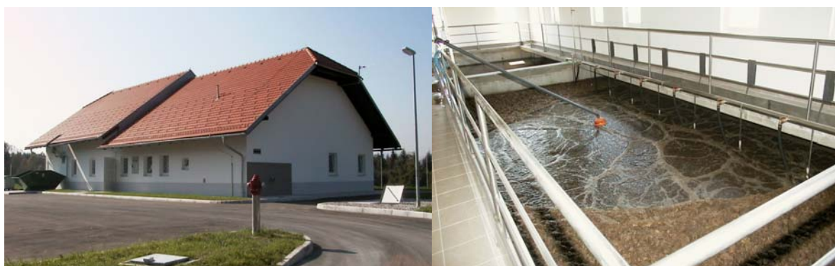
Slika 3.2: Zunanost in notranost sodobne čistilne naprave za komunalne in padavinske odpadne vode v Šmartnem ob Paki za 1.500 PE
