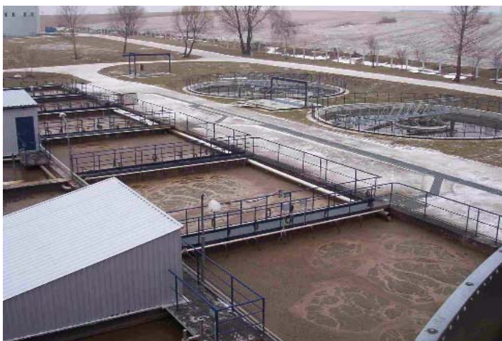
Slika 3.4: Skupna čistilna naprava za tehnološke in komunalne odpadne vode podjetja Volkswagen v bližini Bratislave
