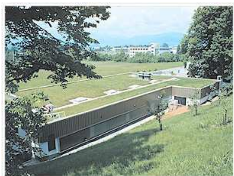
Slika 16: Primer dveh ravnih zelenih streh; Poslovni objekt Šenčur
