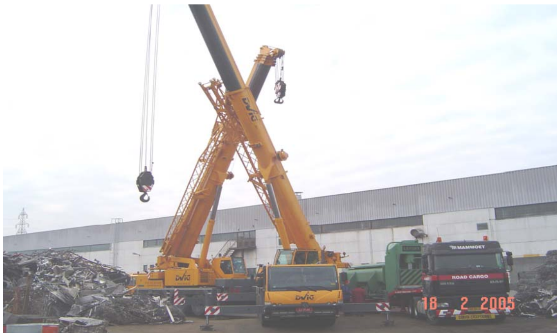
Slika 4: Razkladanje preše za Revoz Novo mesto (teža preše 120 ton)
