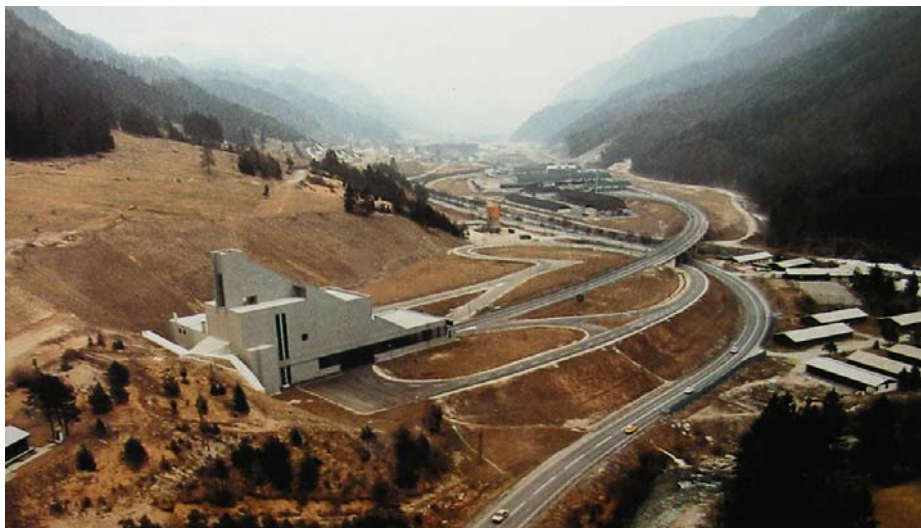
Slika 13: Portalna stavba na južnem vhodu v Predor Karavanke
